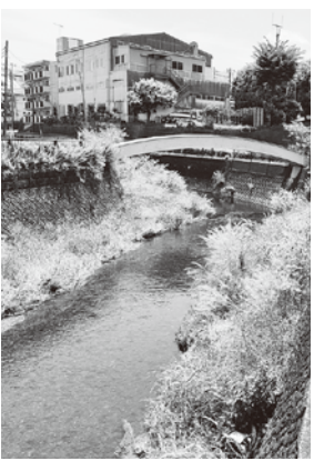
高濃度のPFASが検出された引地川(境橋下流)
